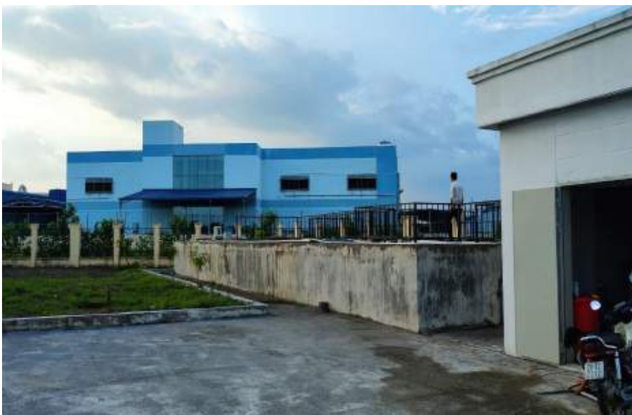
Hệ thống xử lý nước thải dự án “Cụm Công nghiệp Bình Lục” công suất 500m 3 /ngày đêm
